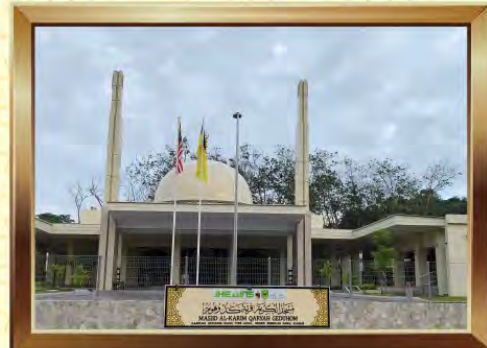
MASJID AL-KARIM QARYAH GEDUHOH, KUALA PILAH
